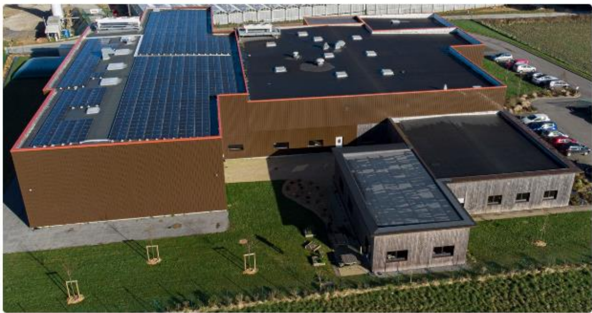
À Ploudaniel (29), l'usine Biobleud est équipée d'une centrale solaire en autoconsommation de 150 kWc.
