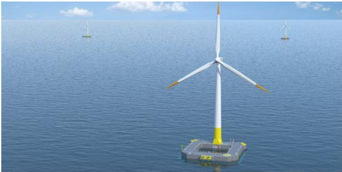
Les éoliennes sont montées sur une structure flottante maintenue par des dispositifs d'ancrage (Photo d'illustration). (Crédits : Ideol BW)
