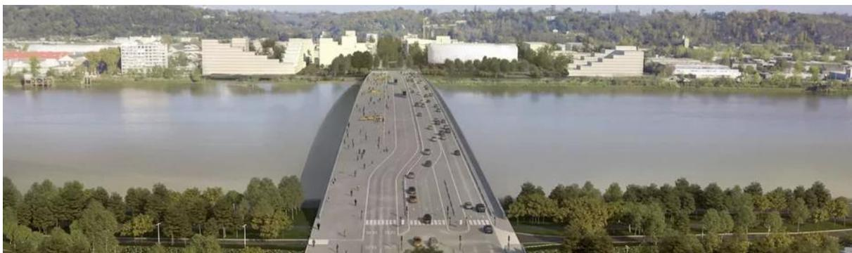
**Avec une livraison prévue au printemps 2024, l'ouvrage doit permettre une meilleure connexion entre les quartiers des deux rives. Il laisse une large place aux modes doux grâce à une piste bidirectionnelle pour les vélos et une voie de 16 mètres de large pour les piétons.**
