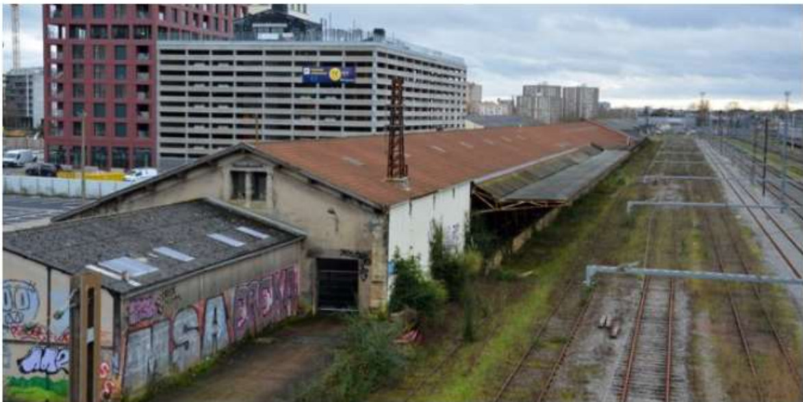
Cette halle SNCF de 6.000 m2 connaîtra prochainement une nouvelle vie. (Crédits : Sacha Gaudin / LT)
