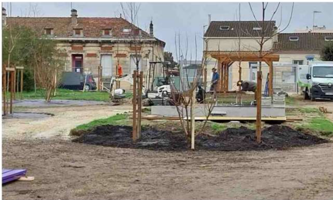
Les travaux sont en cours au square Monrepos. M.G.
