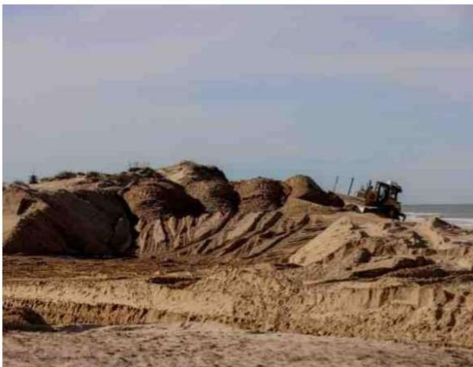
À Soulac-sur-Mer en Gironde, il y a un an, opération de réensablement après la démolition de l'immeuble Le Signal, menacé par le recul du trait de côte. ARCHIVES GUILLAUME BONNAUD / SQ
