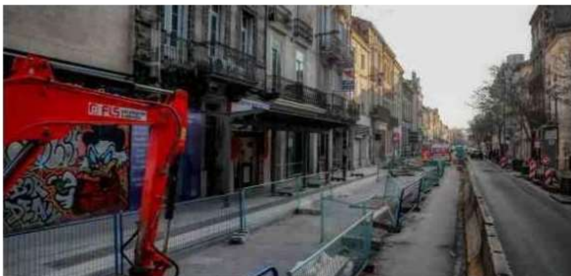
Cours de la Marne à Bordeaux, le chantier du bus express continue.
