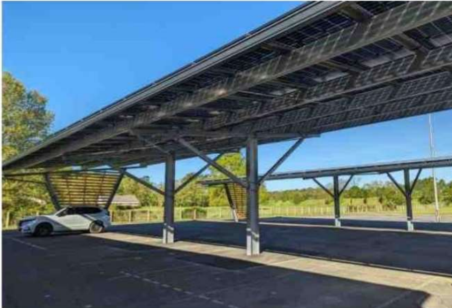
Structure à mono-poteaux au centre pour optimiser la surface au sol et ne pas bloquer des places de parking. P. P.
