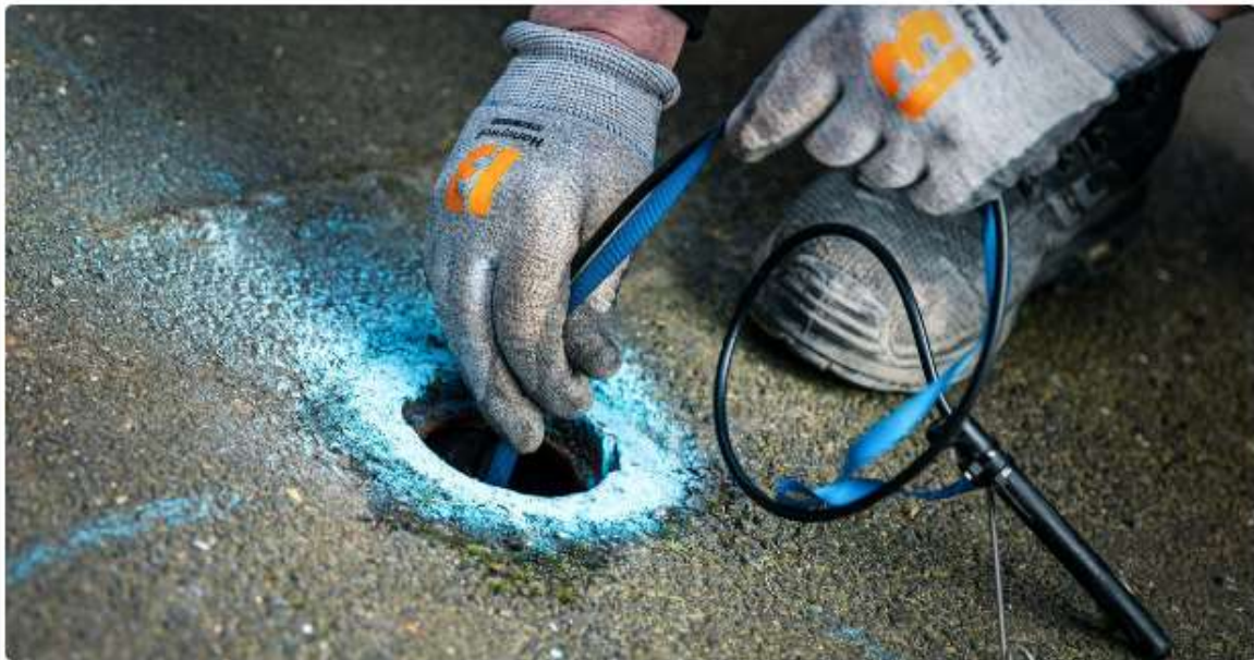
Pose d'une sonde acoustique par un regard.
