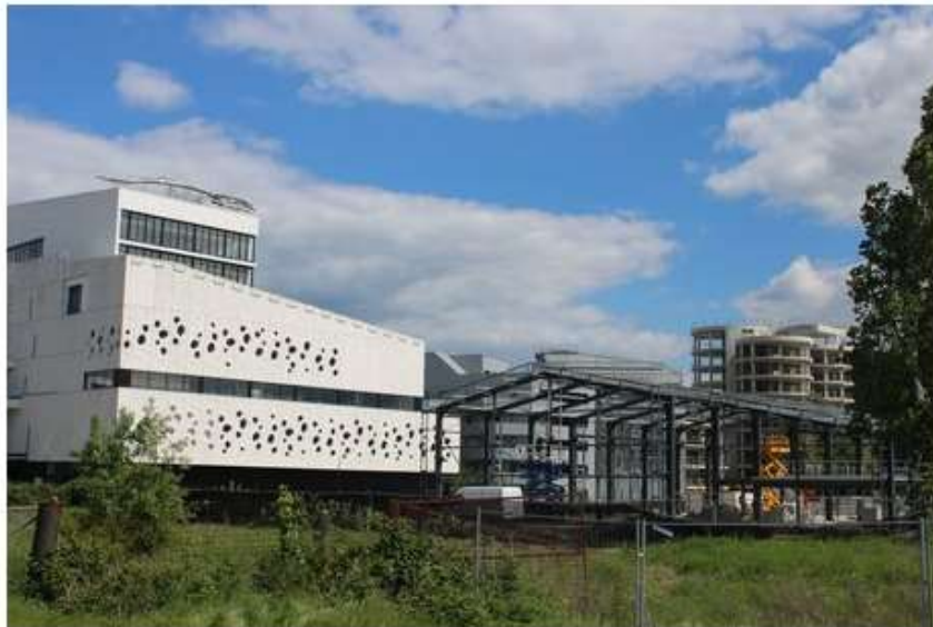
Le chantier de réhabilitation de la halle se poursuit malgré la décision du tribunal. (crédit photo : MG / La Tribune)
